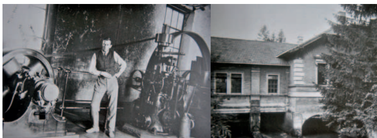
Das Fischa-Kraftwerk in der Kleinen Au und bei den „3 Stegen“ (heute Fehrgasse). Beide Anlagen wurden beim Bombenangriff am 12. April 1944 auf Fischamend zerstört.
